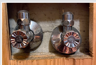
Stillgelegte Anschlüsse, die nicht rückgebaut werden.
